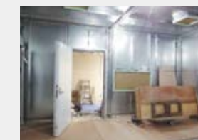
工事中のMRI室
