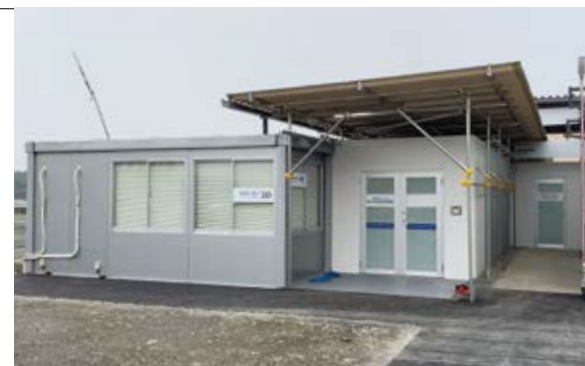
本院から約10kmの距離に位置する「ゆいの杜記念病院」は、COVID-19患者専用の入院施設。簡易的ながらシャワーやトイレもある24床分の病室を備えている。病室内のウイルス量を低下させ2次感染リスクを下げるために、HEPAフィルターと陰圧装置も付属させた。
