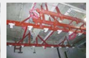
天井補強工事
